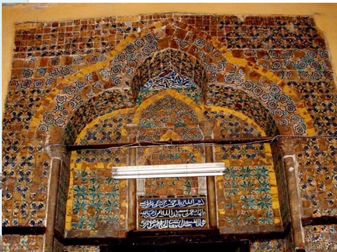
Céramiques de la Mosquée Terbana montrant l'influence magrébine sur l'architecture de l'époque
